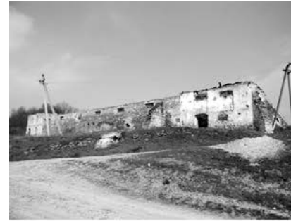
Мал. 6. Південний фасад маєтку баронів Местмахер у с. Песець Новоушицького району. Господарські приміщення, стайні над шляхом. Вид з боку яру р. Данилівка. Фото автора. Березень 2017 р.
